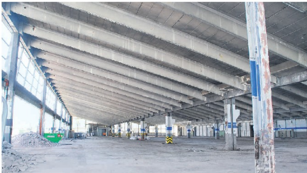
Ein Gewerbehof mit vielen kleineren und mittelgroßen Betrieben soll in der Halle entstehen, die zurzeit entkernt wird.
